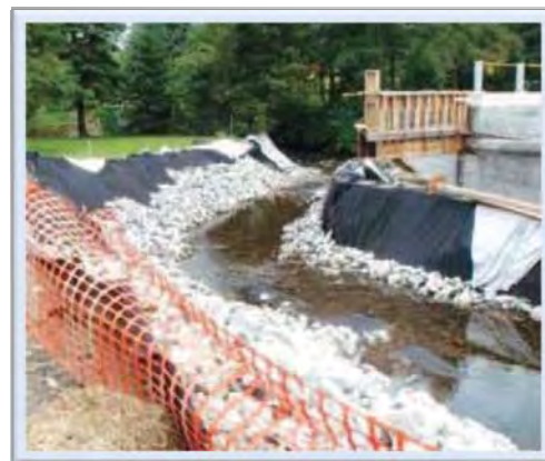
Canal de déviation temporaire d'un cours d'eau
